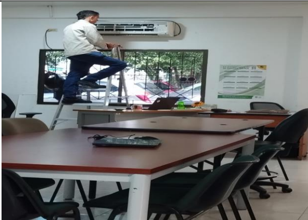
Mantenimiento de aires acondicionados apoyado por la titulada de Refrigeración.
