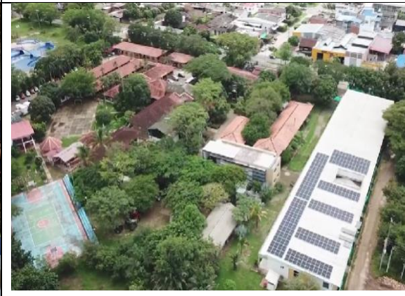
Instalación de la implementación fotovoltaica de los paneles solares en instalaciones.
